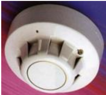
In een brandmelder zit een sensor en een actuator.
